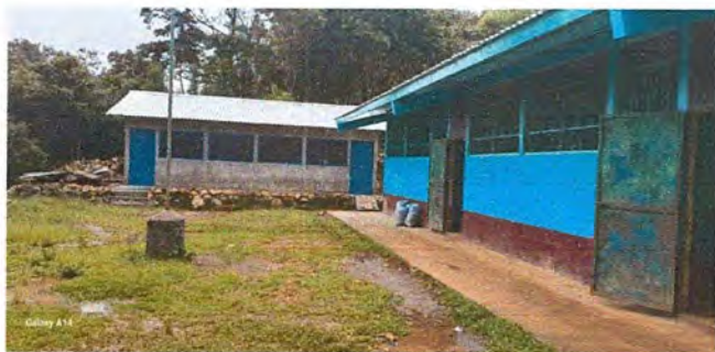
Foto1: la cocina ya esta terminada
