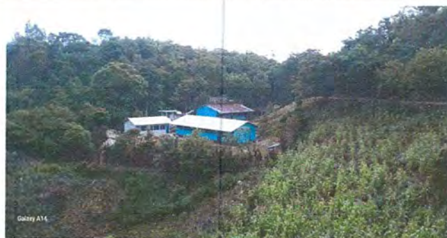
Foto 2: Módulo 1 ya tiene techo
